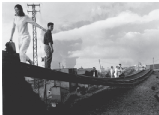
新潟地震で陥没した線路 燃えているコンビナートの煙も見える
